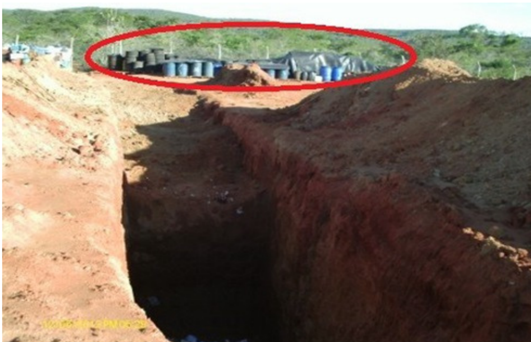
Resíduos contaminados cobertos com manta de PEAD ao fundo da vala aberta recentemente. Foto IBAMA
