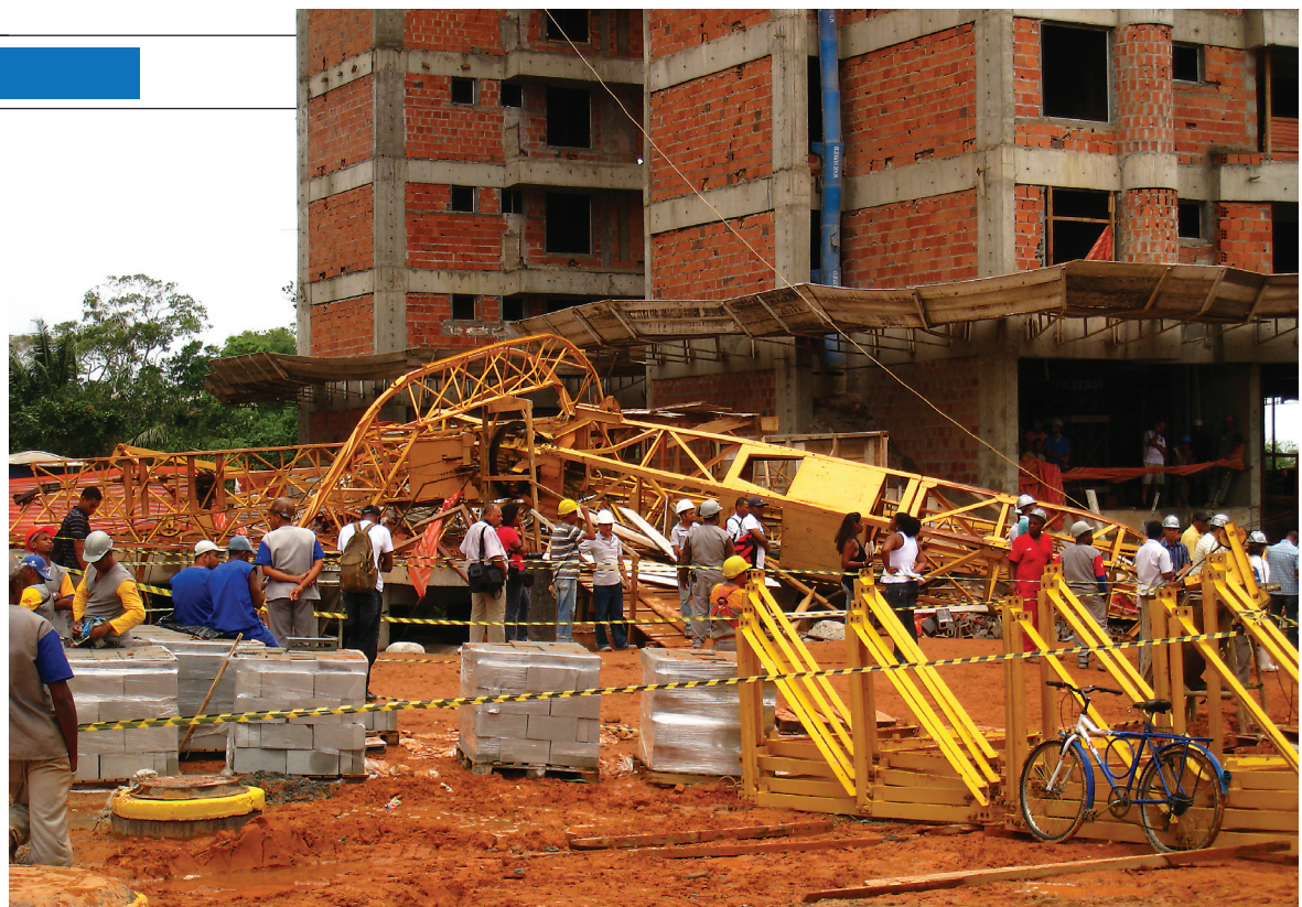
A grua caiu de uma altura de 40m: os dois trabalhadores foram esmagados pelas ferragens
