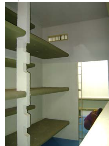
Figura 9 – Camas paralelas à parede sem bloqueio da circulação do ar
