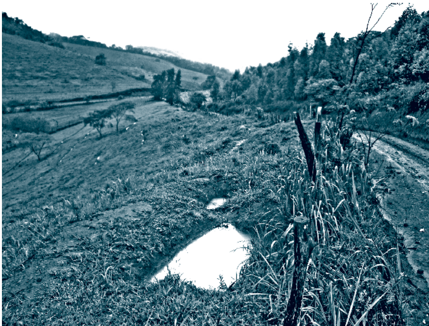
Figura 2.5 – Pequena bacia de infiltração de enxurrada proveniente de estrada de terra (observar a lombada feita na estrada para o desvio da enxurrada)
