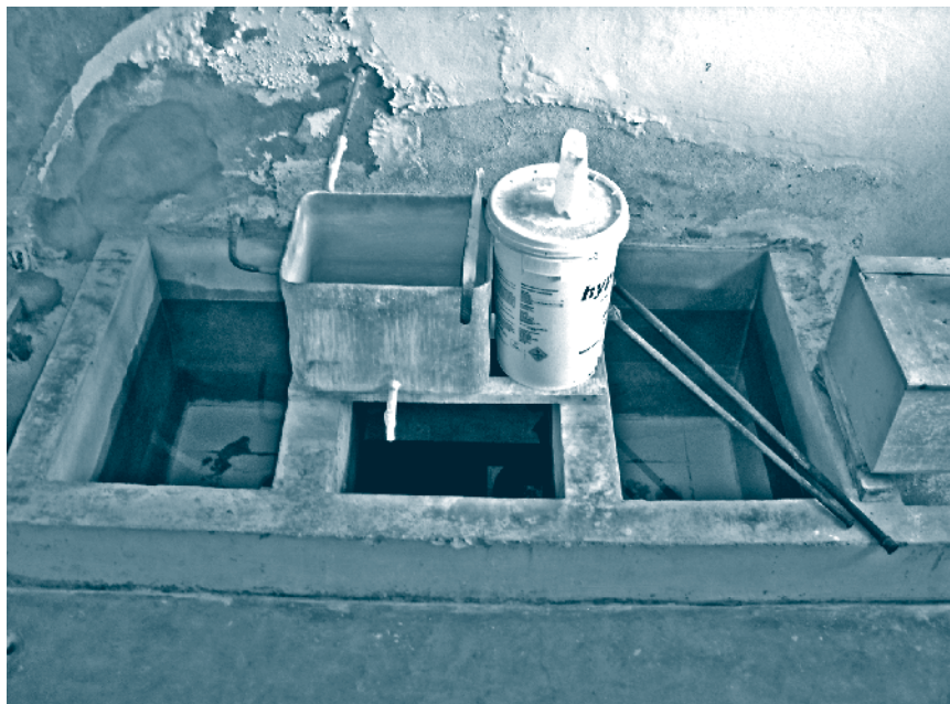
Figura 2.32 – Aplicação correta de produtos químicos no tanque de contato: "cloro" – gás na entrada e "cal" na saída
