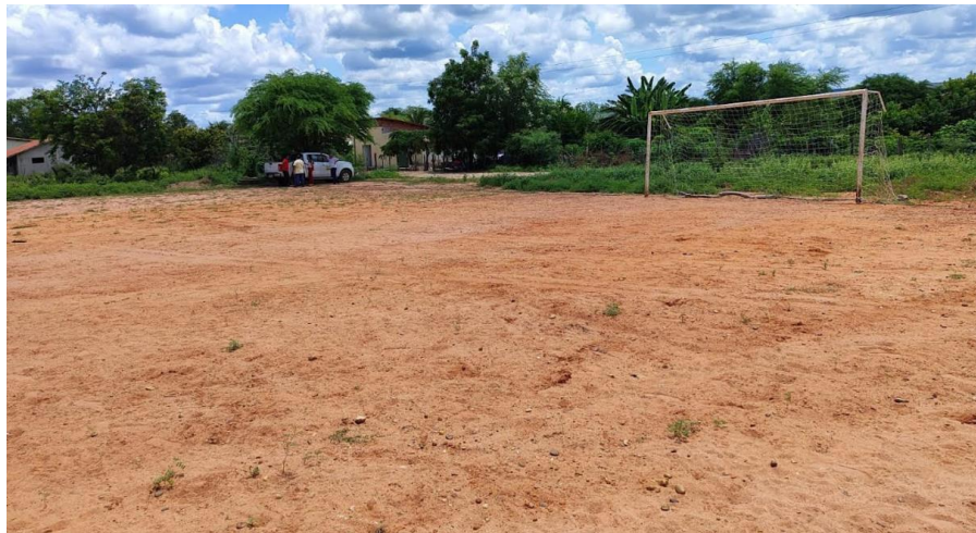
Figura 3 - TERRENO IMPLANTAÇÃO UBSI.
